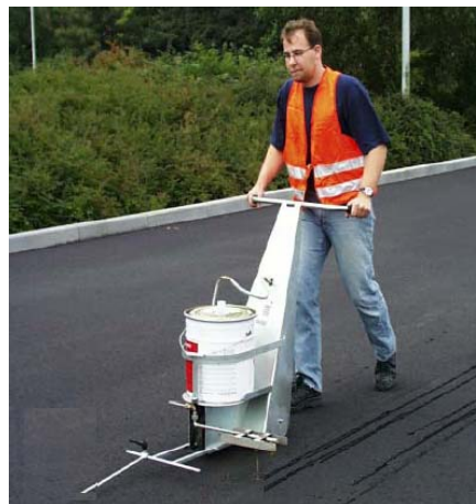
ج: اجرای لایه آستر
